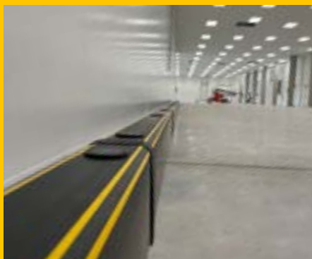
Zábrana FORK v skladovacích priestoroch chráni steny pred nárazom vidlíc.
