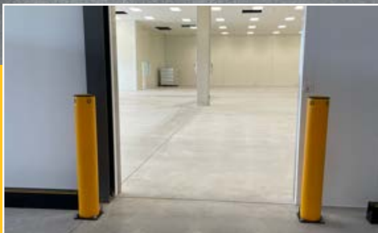
Stĺpiky zamedzujú poškodeniu vstupnej brány v skladovacích priestoroch
